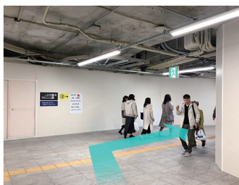
4. 左に曲がってすぐ右手にある、新しい18号出口へ(壁は工事中)
